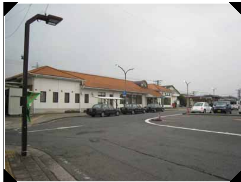
亀山駅付近は、外見上は被害無し
