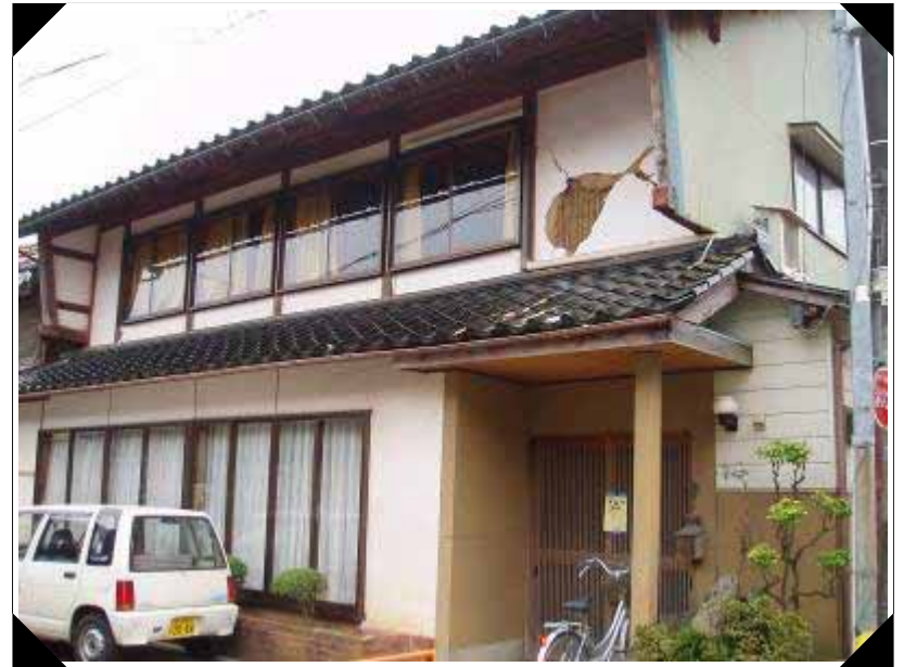
田鶴浜支所の南側周辺
