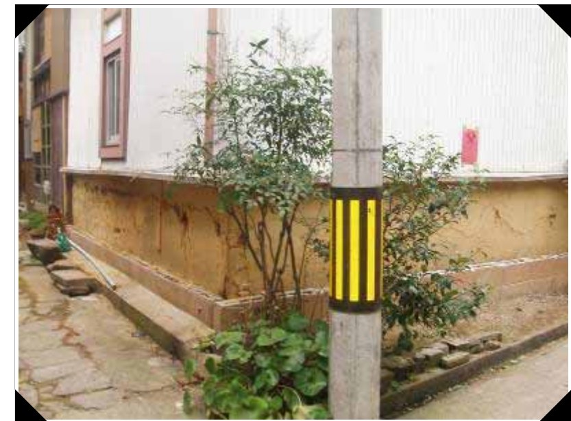
田鶴浜支所の南側周辺
