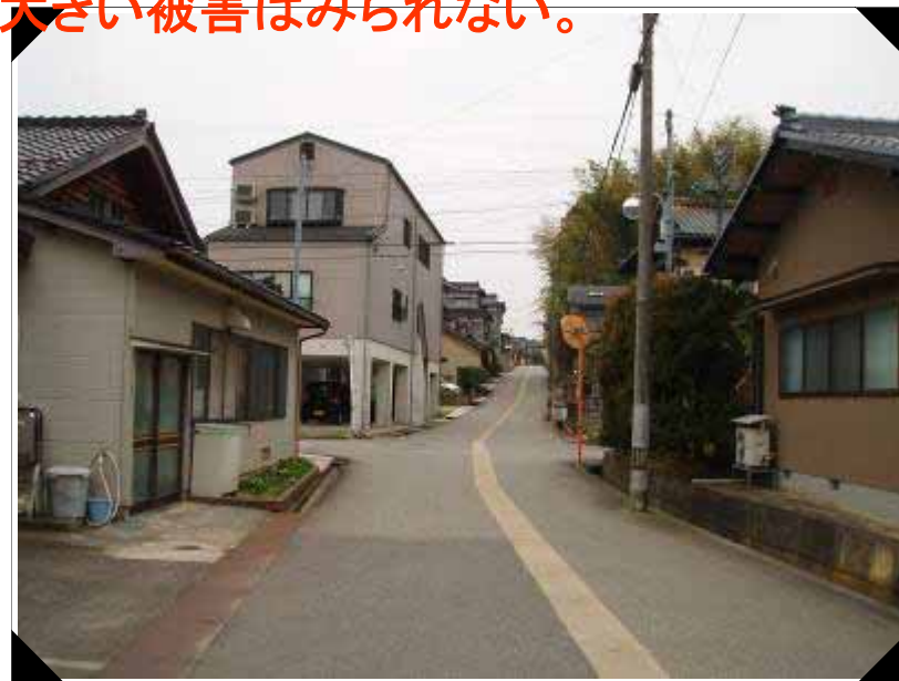
田鶴浜支所の南側周辺
