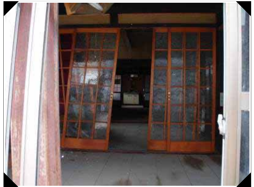
田鶴浜支所の南側周辺
