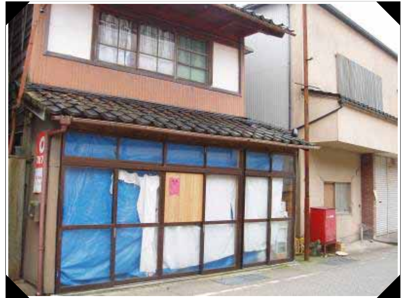
田鶴浜支所の南側周辺
