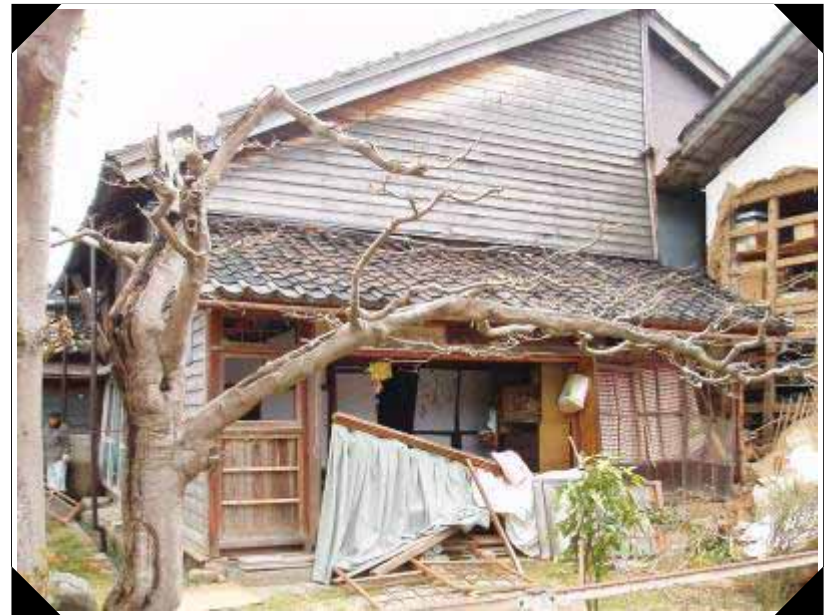
田鶴浜支所の南側周辺
