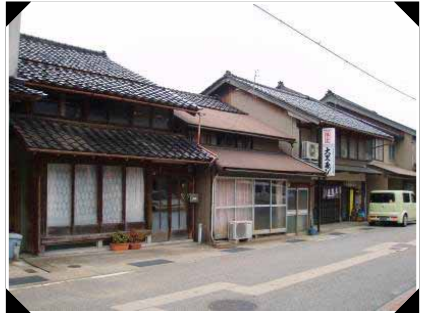
田鶴浜支所の南側周辺
