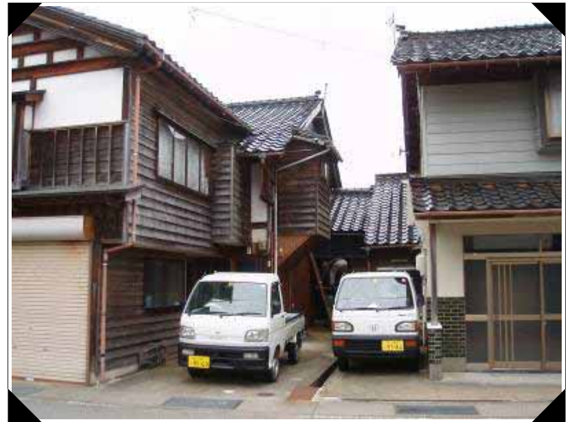
田鶴浜支所の南側周辺
