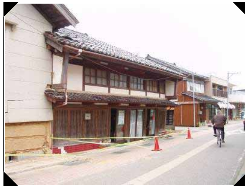
田鶴浜支所の南側周辺
