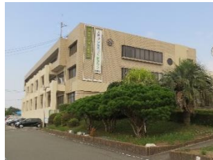
写真 1 建物外観 (視点：南東)
