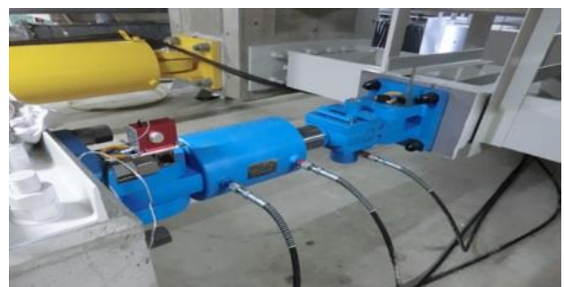
図3 基礎免震層の油圧ジャッキ
