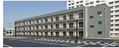
図1 対象建物の外観
