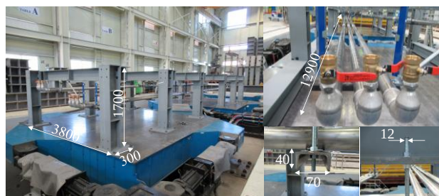
図 6 給水配管耐震措置実験 (2019.10 参加)
