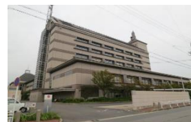
写真1 対象建物(南西から)
