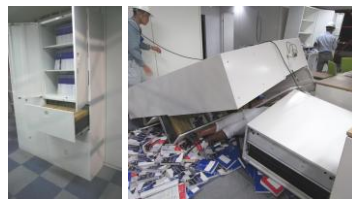
写真 2 キャビネット転倒の様子
