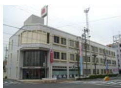
図5 対象建物外観
