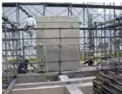
(d) Erection of wall
