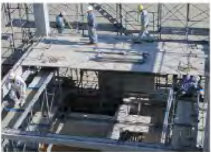
(d) Half precast concrete floor panel
