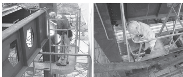
(a) 梁フランジの現場溶接 (b) 非破壊検査 写真1 架構-2の施工状況
