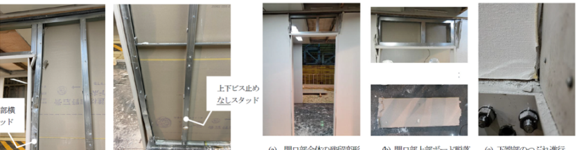
2020年つくば防災科学技術研究所ユニットハウス非構造実験 2)
