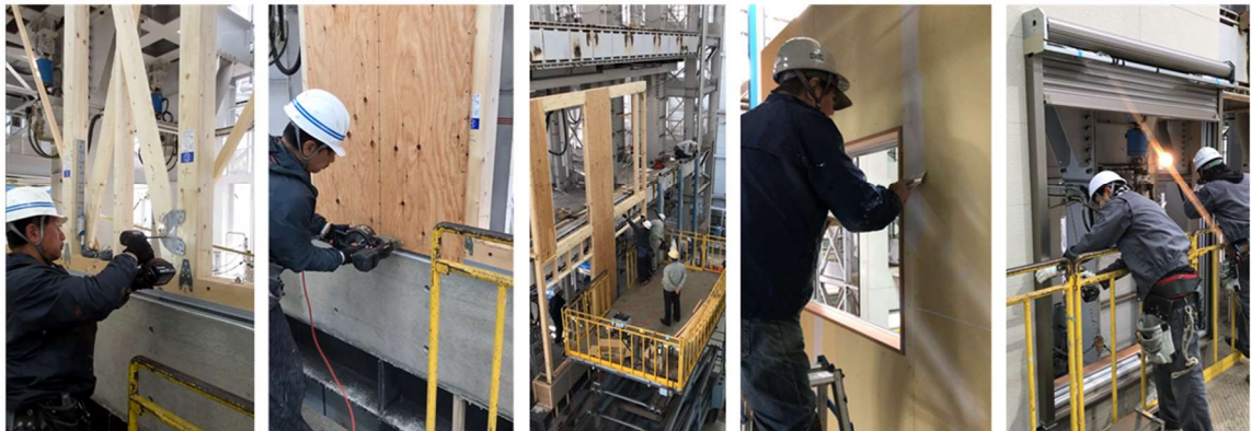
(a) 1階柱脚・接合金物 (b) 構造用合板・釘固定 (c) 1階上部まぐさ (d) 石膏ボード・養生 (e) シャッター取り付け
