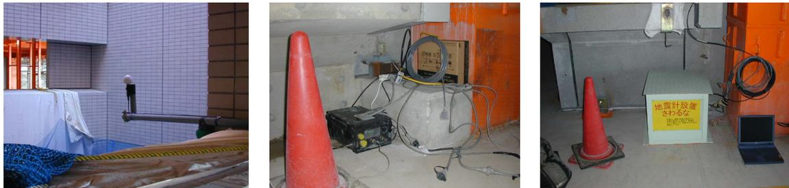
(a) GPS アンテナ (b) 強震計 (c) 養生後の強震計
