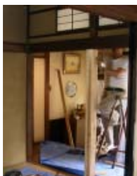
写真 1 柱挿入
