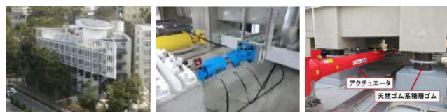
写真 外観(左), 基礎免震層ジャッキ(中央), 屋上免震層(右)
