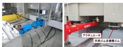
写真2 ジャッキ 写真3 屋上免震層
