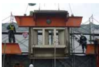
写真3 梁鉄骨+外装PC
