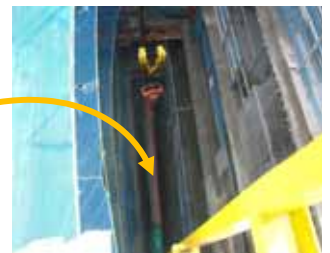
写真5 ガイドレールによる荷降ろし
