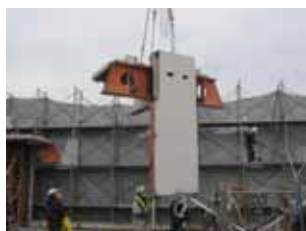
写真2 柱鉄骨+外装PC
