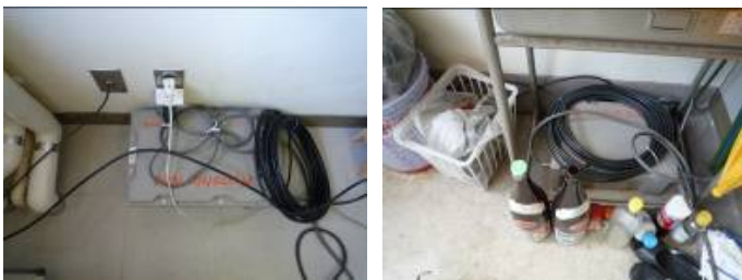
図3 高校校舎の強震計設置状況例（左：4階、右：1階）
