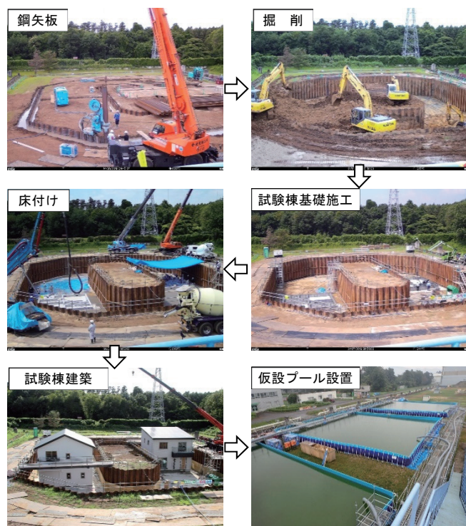
写真3 浸水試験システムの築造過程
