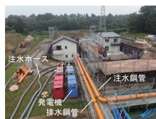
写真4 配管設置状況
