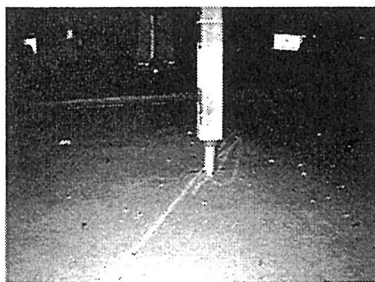
写真1 免震住宅の床下の様子
