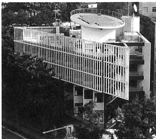
図1 減災館南面の外観
