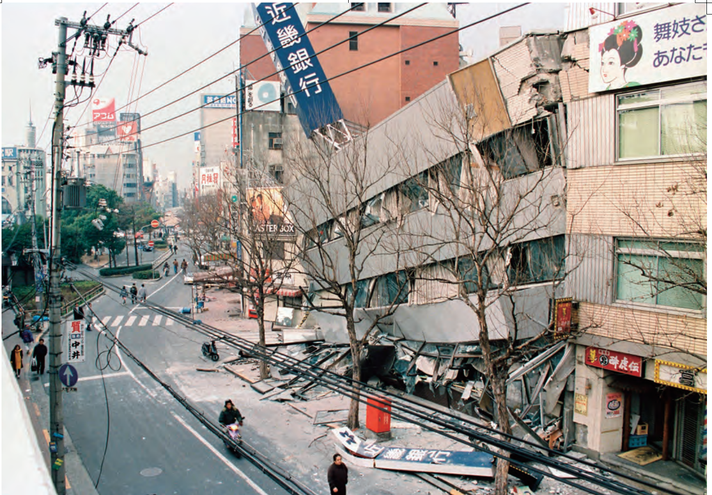
兵庫県南部地震における建物の倒壊(神戸市中央区)(提供:朝日新聞社)
