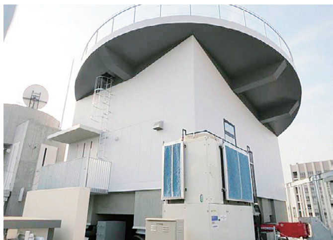
屋上の減災・体感実験室の外観
