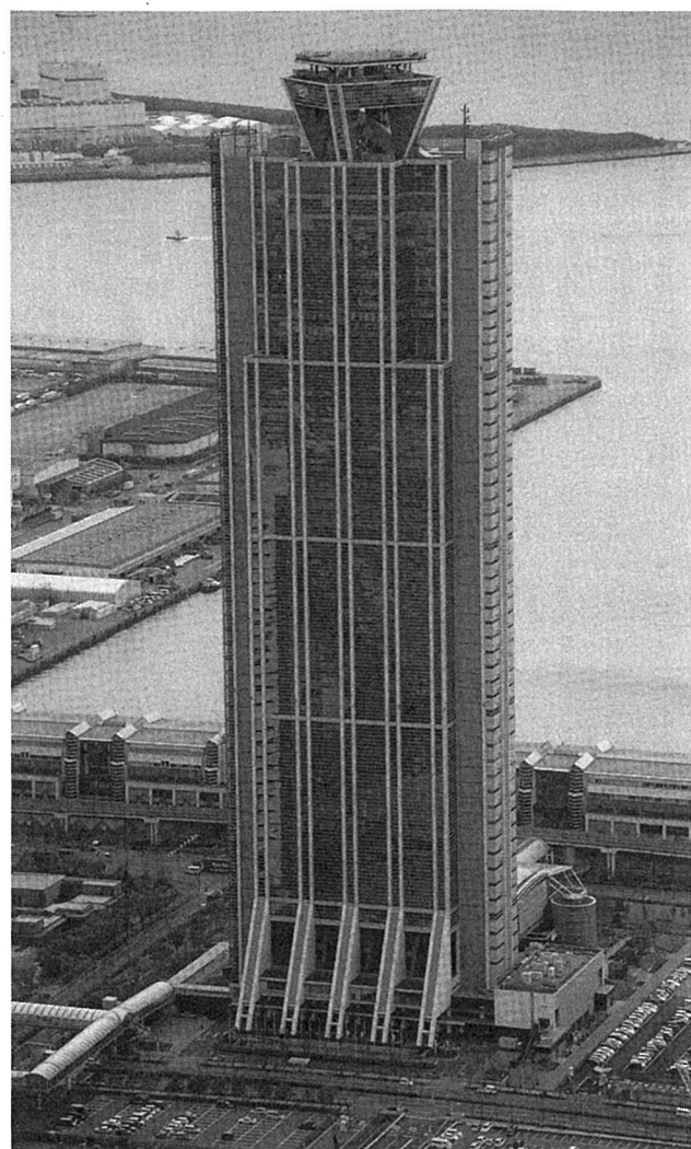
大阪府咲洲庁舎。府市統合本部の会議が開かれたほか、府の金融支援課や住宅経営室が移転し、職員約2千人が勤務する
