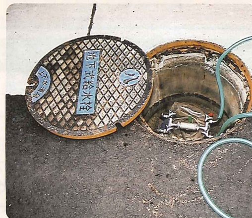
地下式給水栓:市内の全小学校に設置されており、水が手に入ります。
