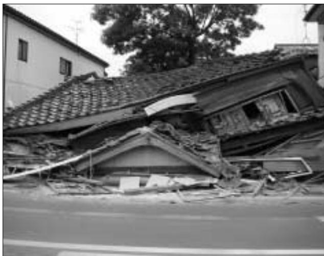
写真8 地盤に起因して倒壊した建物(刈羽村)
