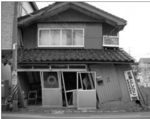
な開口部をとっている。通りと平行する方向に壁が少ない構造になり、この方向の耐震性能がどうしても低くなる。その結果、耐力が不足した木造住宅は、そのまま倒れ、あるいは、隣りの建物へ倒れ掛かる。場合によっては、隣の建物を巻き添えにしながら倒壊することもありえる。写真4～5の
