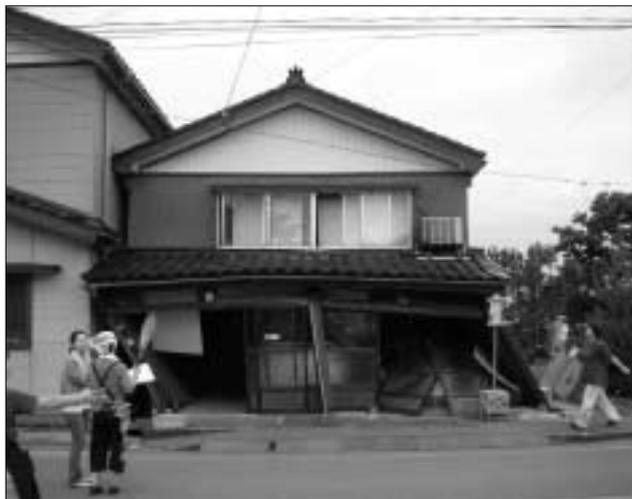
写真3 ドミノ倒しで倒れた住宅(東本町)
