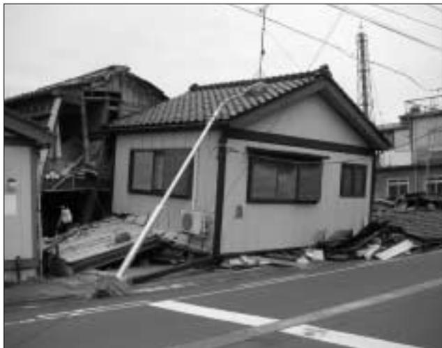
写真7 2階部分も崩壊した建物(東本町)
